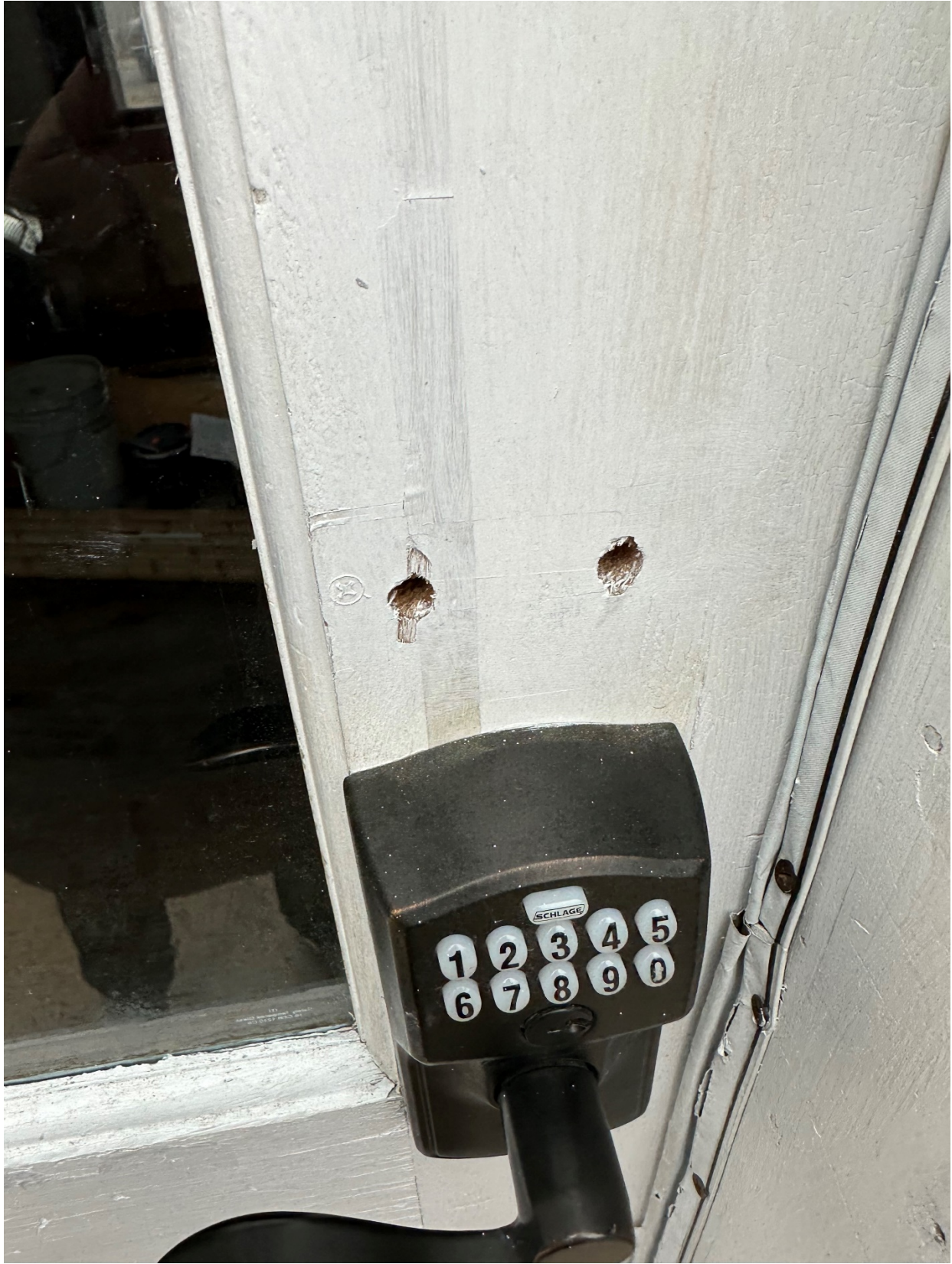
Existing Wood Door
